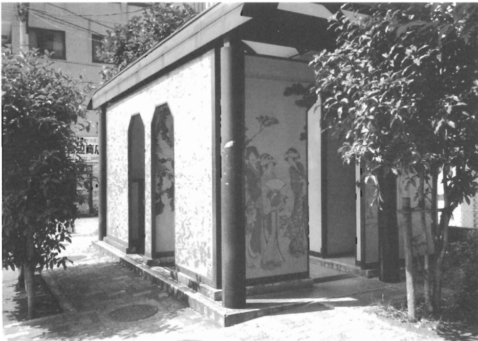
図8 北斎通りに面した公園のトイレ
