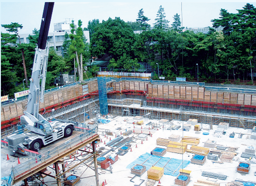
工事中的新3号館（2号館より撮影）
