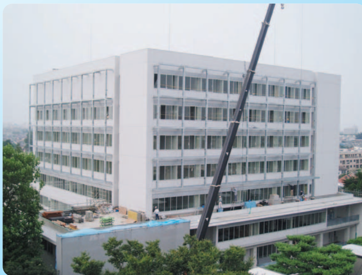
建設中の3号館
