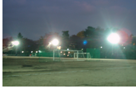
仙川側の照明
